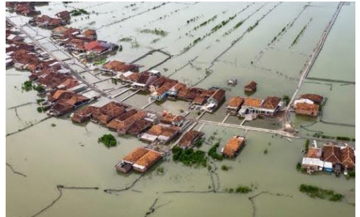
Gambar 5.24 | Perumahan di Demak tenggelam akibat abrasi pantai. (Sumber: https://www.solopos.com/abrasi-pantura-menelan-jawa-tengah-1127648 )
