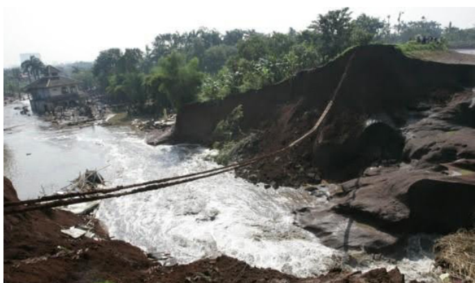
Gambar 5.10 | Banjir bandang akibat jebolnya bendungan Situ Gintung. (Sumber: Daily Mail Online)
